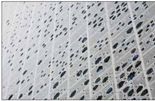
پوسته مشبک یک ساختمان به کمک برش سی‌ان‌سی
